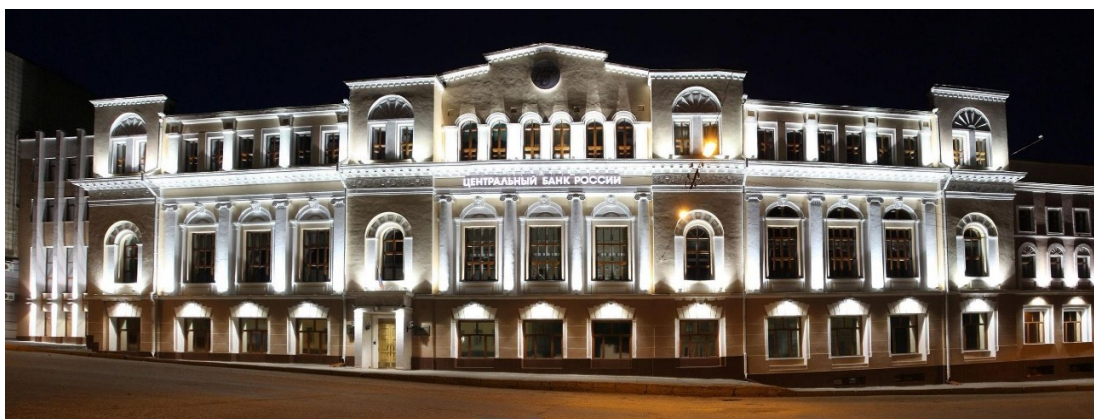
Рис. 3. Архитектурная подсветка Главного управления Центрального банка РФ по Кировской области, г. Киров, 2013
